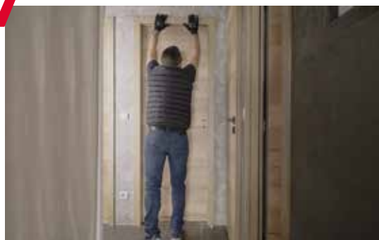
Installation du profil contre-chambranle My Réno
